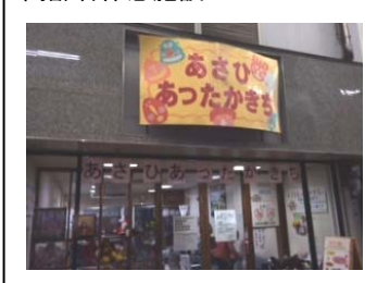
高齢者休憩施設
